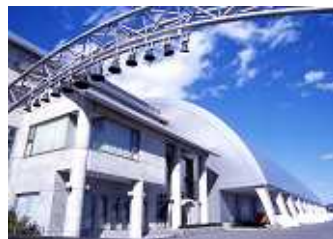
アルプス搗精工場
